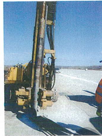
Execuția forajelor de verificare a stratificației
