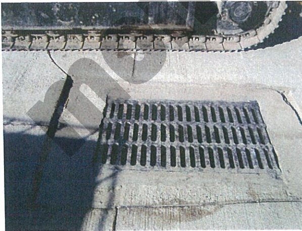
Fisuri în acostament, în zona canalizării
