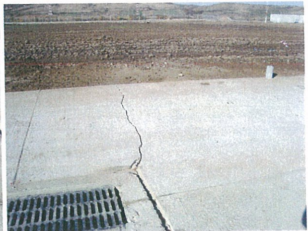
Fisuri în acostament, în zona canalizării
